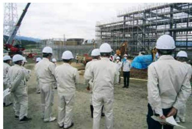
木質バイオマス発電所の建設現場
