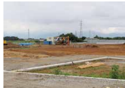
バイオマス発電所建設予定地
