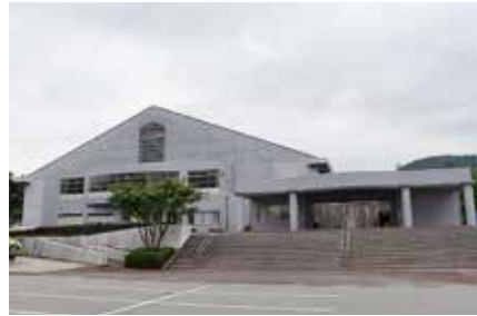
敷島体育館（アスロック妻壁等改修工事、LED化、アリーナ床改修工事）
