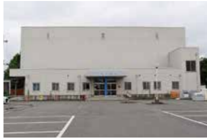
玉幡体育館（屋根・外壁改修工事）
