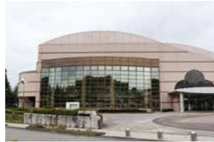
双葉ふれあい文化館（外壁改修工事）
