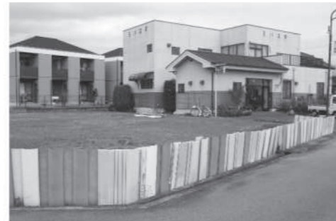
整備予定の玉川地内民間温泉隣接地
