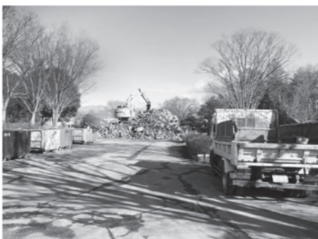
山梨県緑化センター跡地の解体作業の様子
