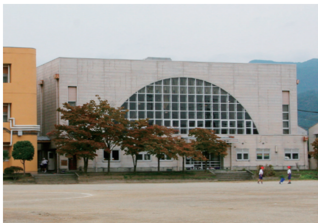
敷島南小学校屋内運動場
