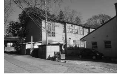
老朽化の旧睦沢小学校校舎 (来年度解体予定)
