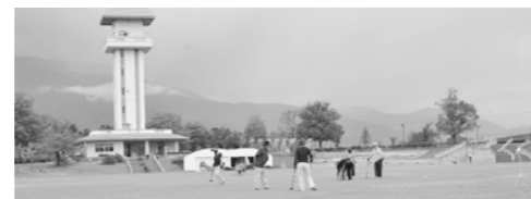
園路改修するドラゴンパーク
