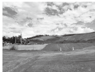
葛蒲沢太陽光発電建設現場
