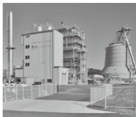
宮の郷木質バイオマス発電所
