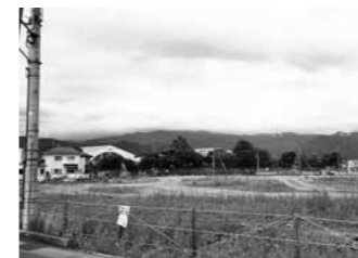
フォレストモール進出予定地の開発工事進行中の様子
