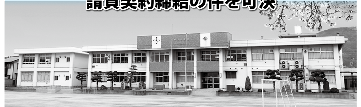
大規模改修が予定されている敷島小学校
