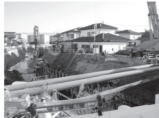
長塚橋架け替え工事
