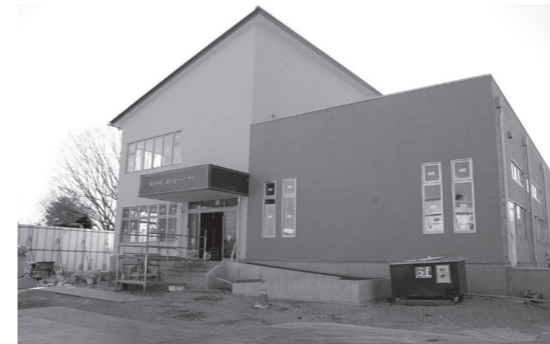
建設中の甲斐市竜王中部公園セミナーハウス
