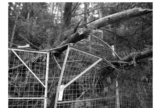
破損した鳥獣害防止柵の様子
