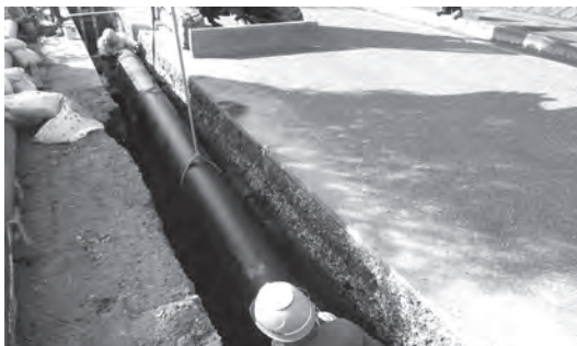
耐震管の布設状況
