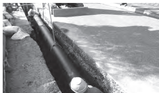
耐震管の布設状況
