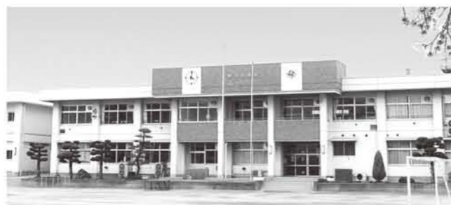
甲斐市立敷島小学校
