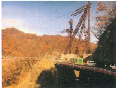
ダム本体工事現場入口
