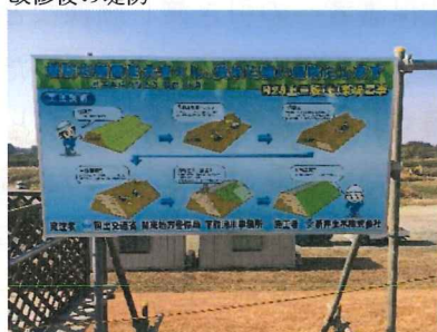
改修後の堤防
