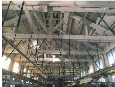
繰糸工場屋根（トラス構造）
