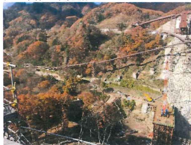
ダム本体工事現場（上流）
