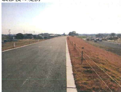
改修後の堤防
