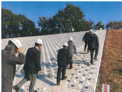
改修後の堤防
