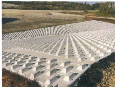
改修後の堤防
