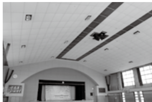
吊り天井の耐震点検を行う竜王東小学校屋内運動場
