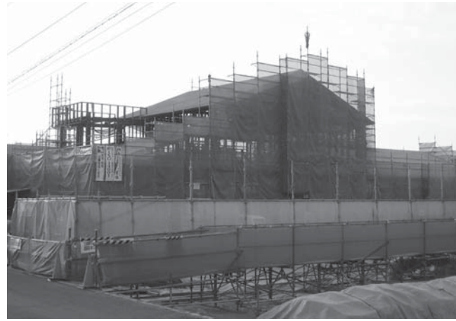
建設中の竜王中央保育園
