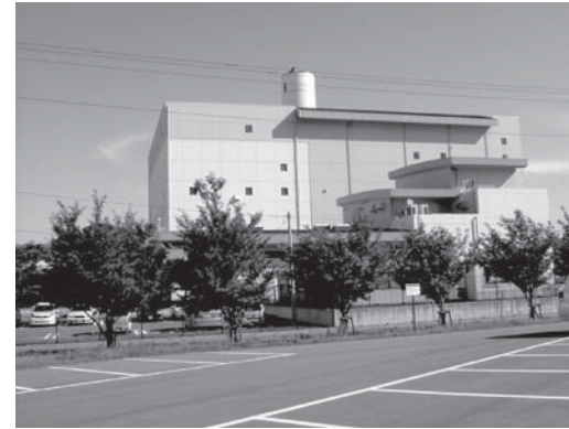
峡北広域環境衛生センター(エコパークたつおか)
