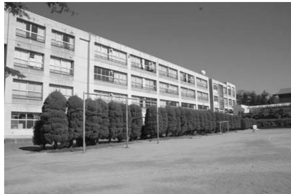
老朽化により改修が望まれる双葉中学校
