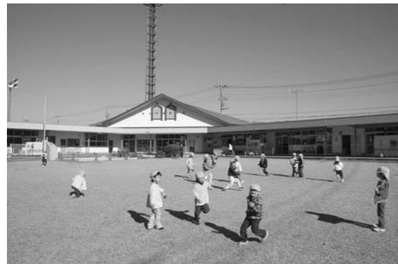
耐震工事が必要な市立保育園（写真は、竜王中央保育園）
