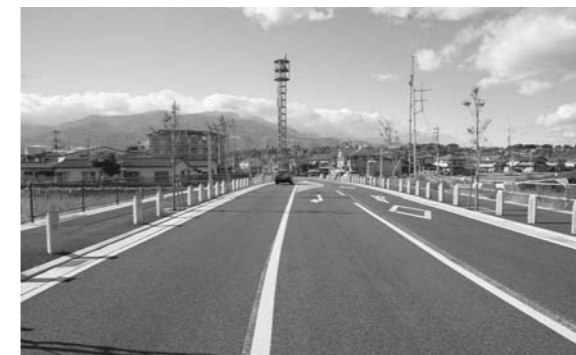
延伸整備が望まれる竜王駅北通り線
