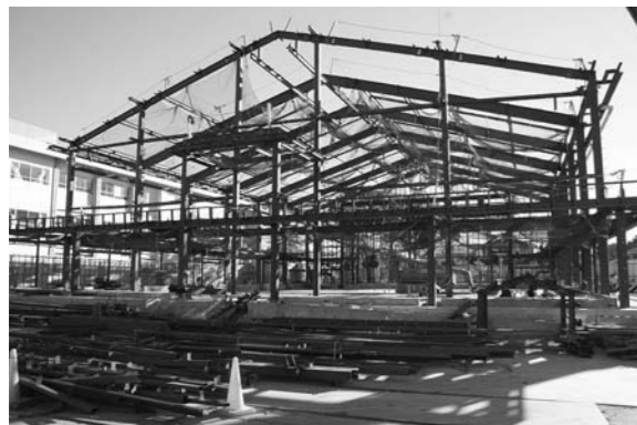
工事が進む竜王小学校体育館
