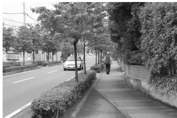
歩道により安全確保がされている市道
